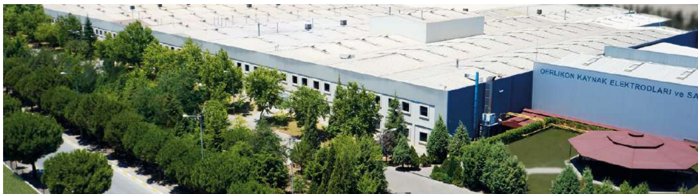
Usine de Consommables de Soudage Zone Industrielle Organisée, 2 e Section, Manisa, Turquie
