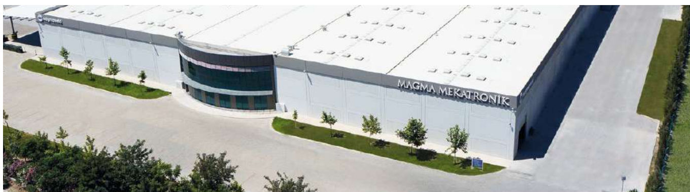
Usine de Machines de Soudage et d'Automatisation Zone Industrielle Organisée, 5 e Section, Manisa, Turquie
