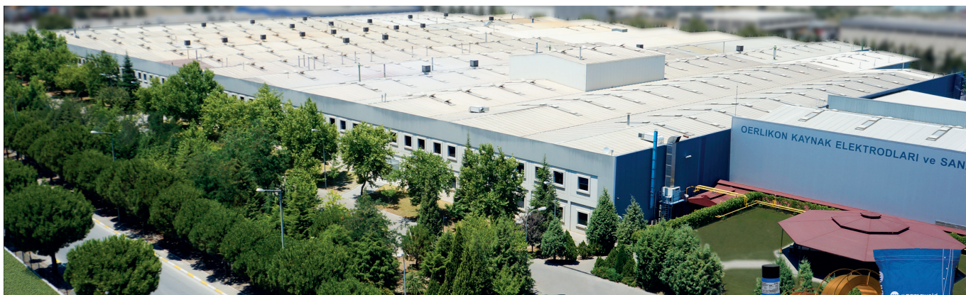
Usine de consommables de soudage Organize Sanayi Bölgesi 2. Kısım, Manisa, Turquie
